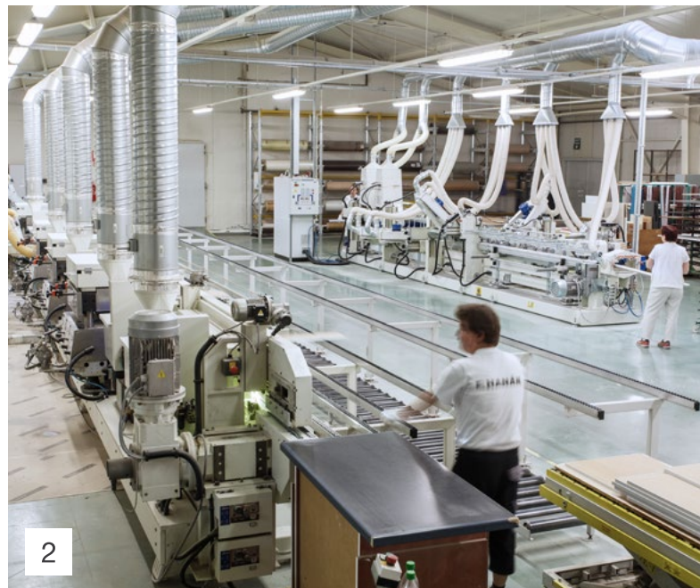
1 | CENTRÁLNÍ LAKOVNA Finální povrchové úpravy. 2 | LINKA S UV VYTVRZOVÁNÍM Akryluretanové laky - hrany. 3 | DETAIL LINKY UV Lakování a broušení ploch dílců. 4 | KLIMATIZOVANÁ STŘÍKACÍ KABINA
